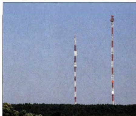
Kurz vor der Sprengung von Gartow 1 (Mitte) am 20. 8. 2009
