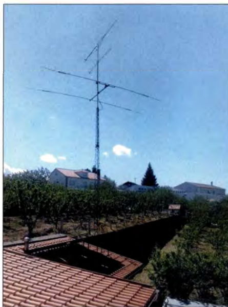
CT7ABA arbeitet auf 2 m mit etwa 100 W an einer 11-Element-Yagi. Darüber hinaus ist er auch auf Kurzwellen QRV und betreibt eine experimentelle 10-mW-WSPR-Bake auf 28,1262 MHz, 21,0961 MHz, 14,0971 MHz, 10,1402 MHz und 7,0401 MHz. Foto: CT7ABA
