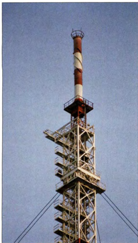
Spitze des 327 m hohen Sendemasts auf dem Hühbeck, der am 20. 8. 2009 gesprengt wurde
